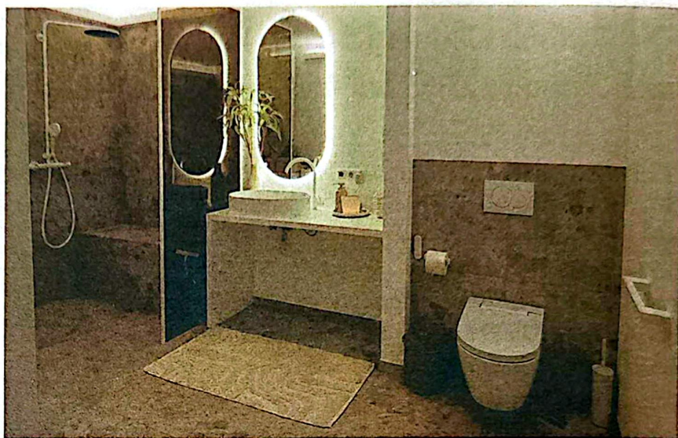
Das neue Badezimmer wurde mit Sitzdusche, Dusch-WC, unterfahrbarem Waschtisch und behindertengerechten Haltegriffen ausgestattet. Foto: Kiwanis
